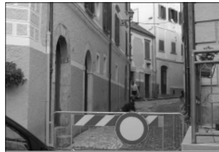
I lavori in via Lucci
